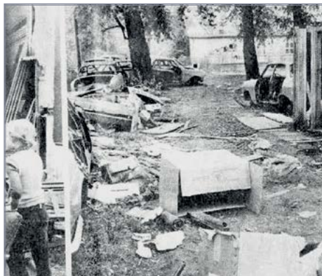
Die Baracken vor dem Abbruch.
