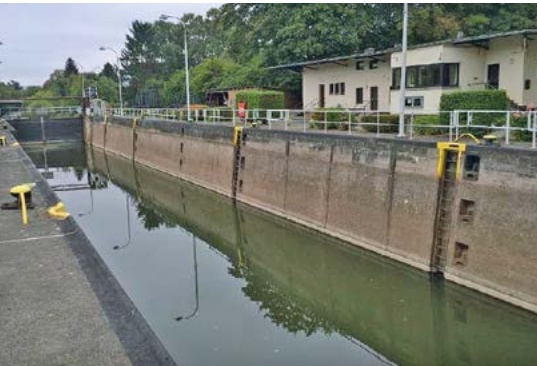
Schleuse vor dem Umbau. Archiv gb
