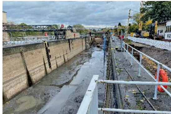
Schleuse nach dem Entkernen. Archiv gb
