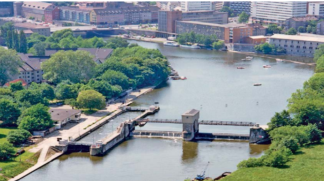
Stadtschleuse um 2016, Luftaufnahme. Bildarchiv Stadt Kassel
