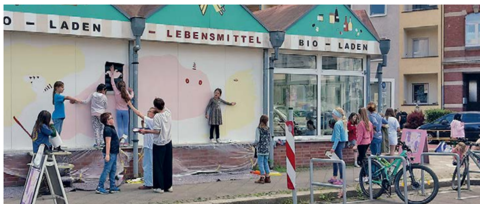
Buchkinder: Fassade in Arbeit ...
