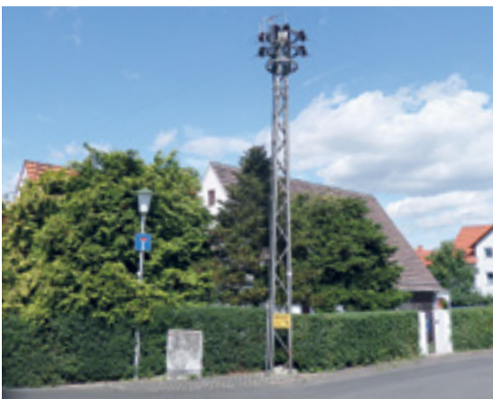
Ein museumsreifer Oberleitungsmast an der Kreuzung „Speeler Weg / Am Osterholz“.
