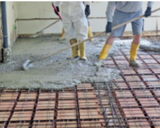
*Der Beton fließt – Bodenbodensanierung Saal*
