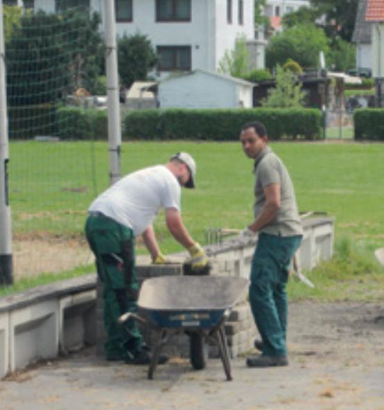
*Erstes Beispiel der Arbeiten, die wir im Kasseler Osten umgesetzt haben: Pflasterarbeiten mit recycelten Betonpflastersteinen beim TuSpo Waldau.*
