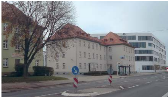
Häuser Sandershäuser Straße 124-126, SMA
