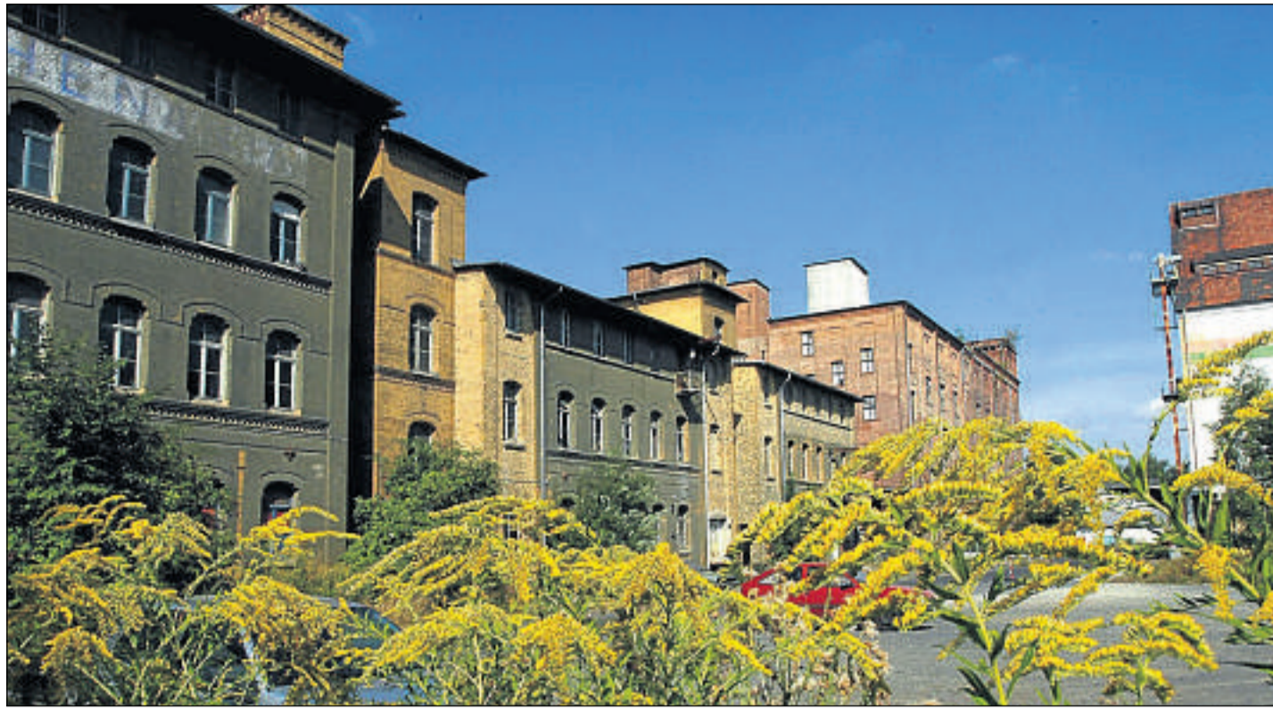
Sollen abgerissen werden: Die Gebäude der Haferkakaofabrik an der Sandershäuser Straße 77-83. Nur das hohe Ziegelgebäude am rechten Ende der denkmalgeschützten Häuserzeile ist nicht vom Hausschwamm befallen und bleibt erhalten. Archivfoto: Fischer
