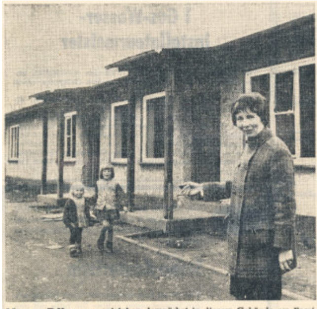
Neue Räume entstehen demnächst in diesem Gebäude am Forstbachweg. Die alten Mieter sind inzwischen ausgezogen. Jetzt müssen einige Wände herausgenommen, andere neu gezogen werden. Dann werden die Jugendlichen aus den umliegenden Wohngebieten hier Gelegenheit haben, ein „Haus der offenen Tür“ zu finden. (Aufnahme: L)
