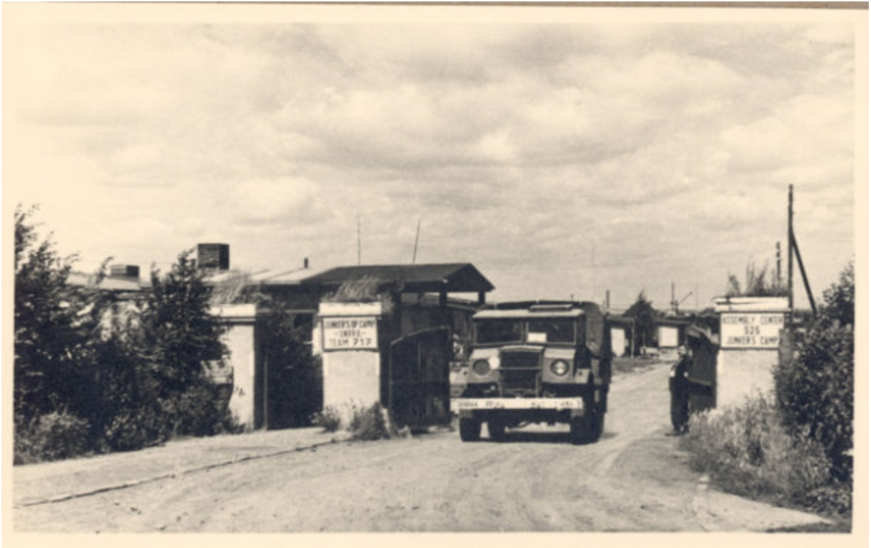
Bild: UNESCO, Ende der 40-er Jahre, der rechte Pfosten steht jetzt unter Denkmalschutz
