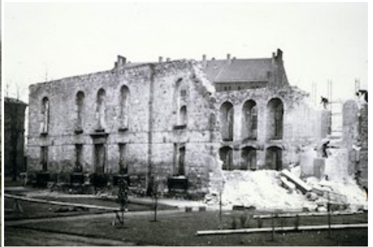
Ruine der Unterneustädter Kirche, 1943
