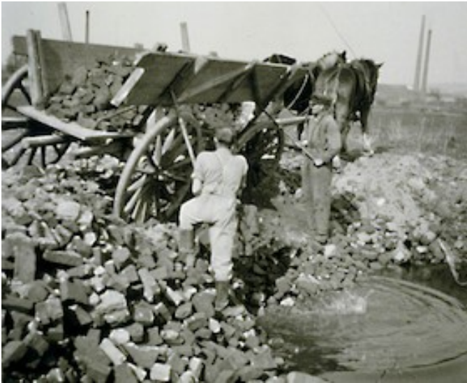
Schuttblenden in Bombentrichter Tapsgasse, Mai 1946
