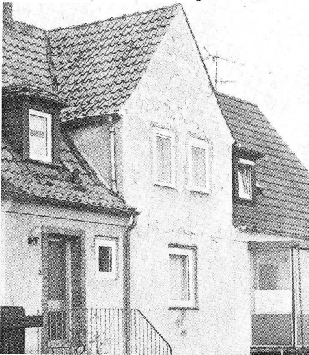
Hier sind schon die neuen Fenster eingesetzt.
