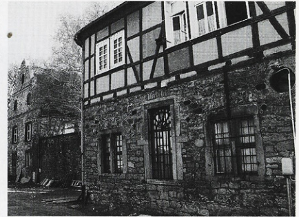
Abb. 19: Das Torhaus und links der Giebel des Gießereiflügels
