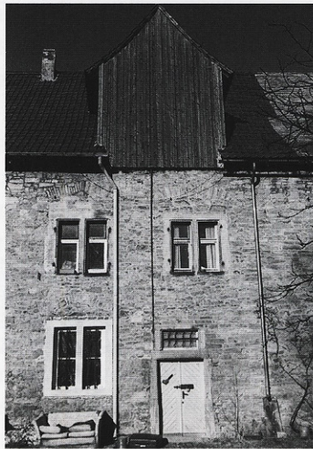
Abb. 6: Zweite Tür vom Hof in den Gießereiflügel, zwei originale Zwillingsfenster- gewände im 1. Stock und das südöstliche 2. Dach- haus, 1995
