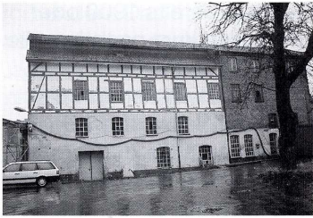
Abb. 18: Nördliches (l.) und südliches (r.) ehemaliges Mühlengebäude, Hofseite
