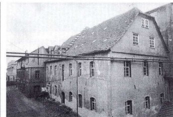
Abb. 7 Mühlengebäude zwischen 1954 u. 1958
