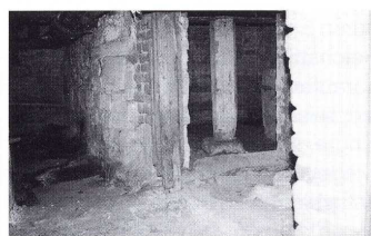
Abb. 17 Pfeiler im südlichen Keller des "Leimhauses", 1996
