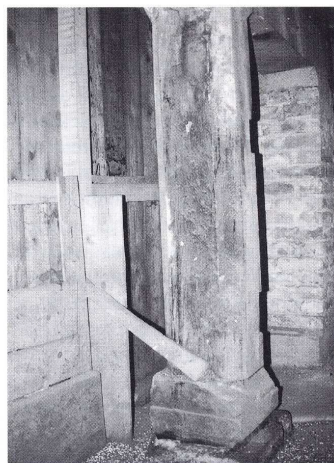
Abb. 16 Pfeiler im Keller des "Leimhauses", 1996
