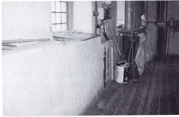
Abb. 9 Mauerstärke des alten Mühlengebäudes im heutigen Silo, 1996
