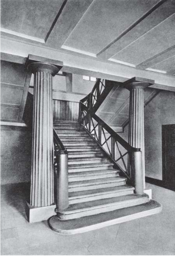
Abb. 5: Treppenhaus des Waisenhauses, um 1920. Der Einbau einer neuen, klassizistischen Treppe erfolgte möglicherweise zugleich mit dem Bau der beiden rückwärtigen Seitenflügel um 1824.
