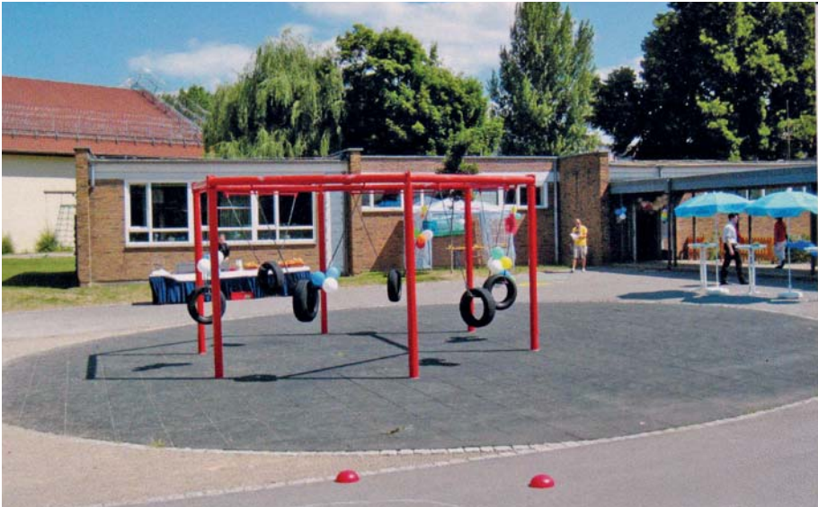
Abb. 6: Ansicht Hort Unterneustadt, Leipziger Straße 13, Zustand 2006, Archivbild der Stiftung
