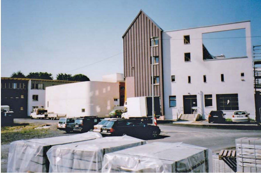
Abb. 3: Baustelle der Kita, Bettenhäuser Straße 18 unmittelbar vor der Fertigstellung 2001, Archivbild der Stiftung
