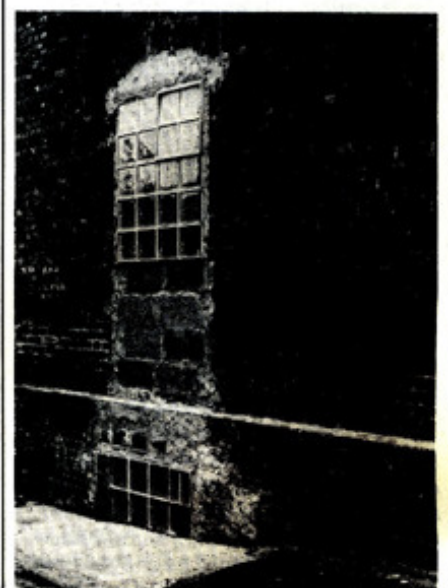
Im linken Foto ein Ausschnitt aus dem Eingangsbereich dieses Wohnhauses. Der Vergleich der beiden unteren Fotos macht die Folgen brutaler Eingriffe in die ursprüngliche Architektur, sei sie auch noch so nebensächlich, deutlich. Treppenaufgang, Geländer und Tür waren Teil des Wohnens.
