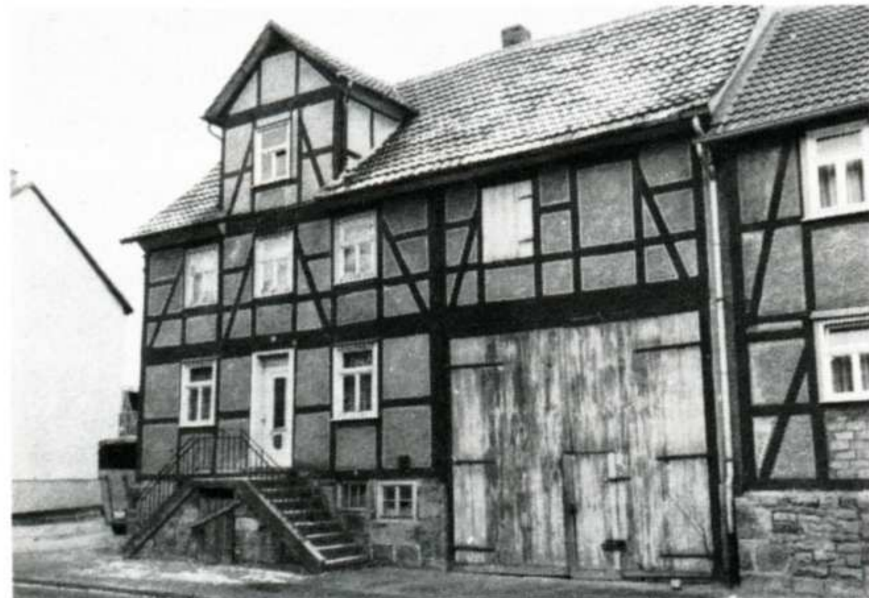
Treppenanlage Kasseler Straße 38.
