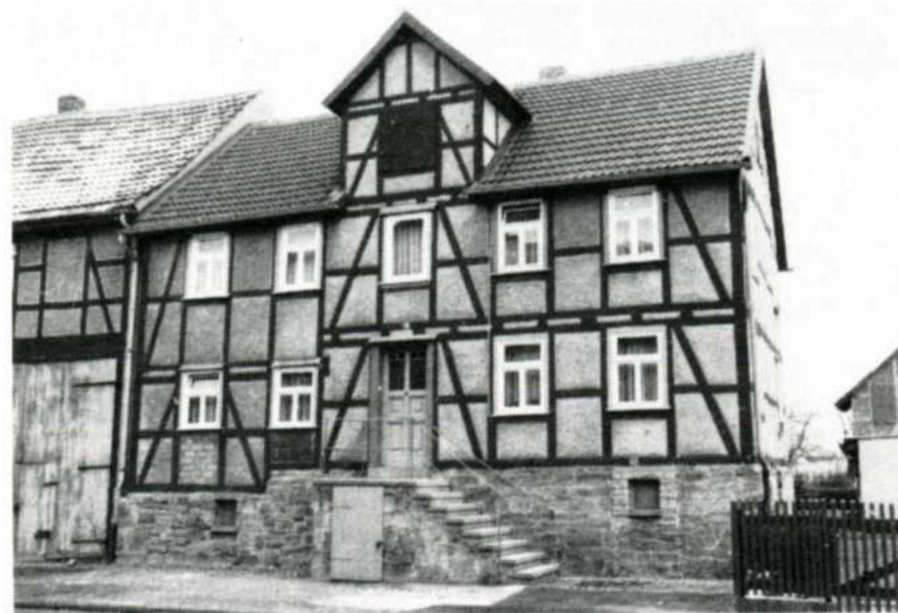
Steinfundamente Kasseler Straße 36.
