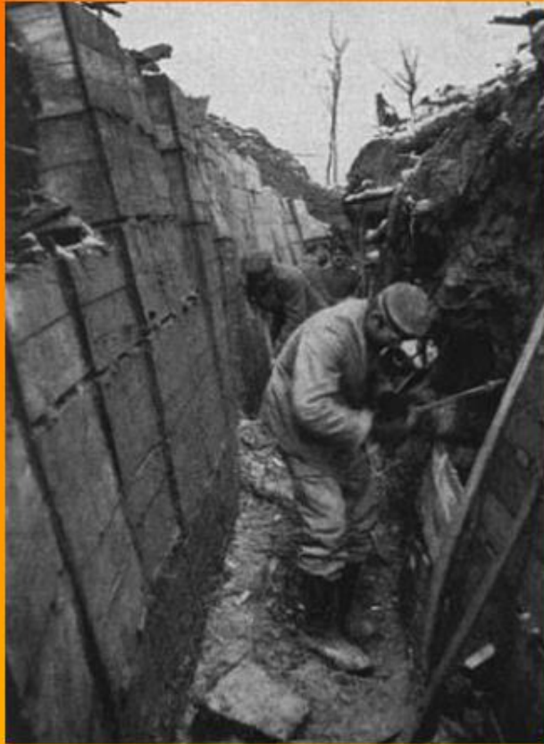
Bild: Reparaturarbeiten am Schützengraben und er Westfont Frankreichs.
