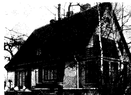
Haus Umbachsweg 7 Bes.: O. Kraft
