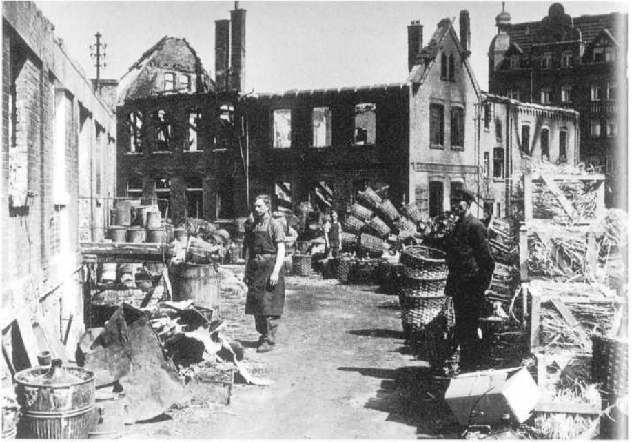
Zerbombte Chemikaliengroßhandlung Kaysan & Wagner, Leipziger Straße ehemals drittes Schulgebäude in Bettenhausen
